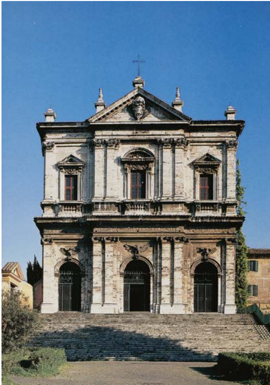
Fassade des Klosters S. Gregorio al Celio
